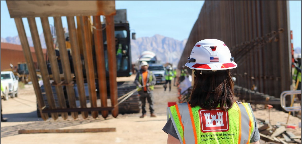
I vertici e il personale del Corpo degli Ingegneri dell'Esercito degli Stati Uniti supervisionano i lavori di costruzione del progetto BMGR-1 e l'installazione dei dissuasori, il 9 febbraio 2026, nei pressi di Yuma, in Arizona (foto del Corpo degli Ingegneri dell'Esercito degli Stati Uniti di Robert DeDeaux).
